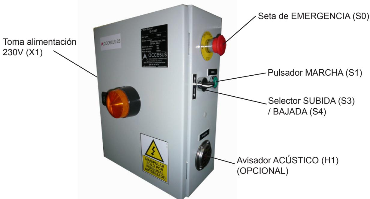
Armario eléctrico para un motor
