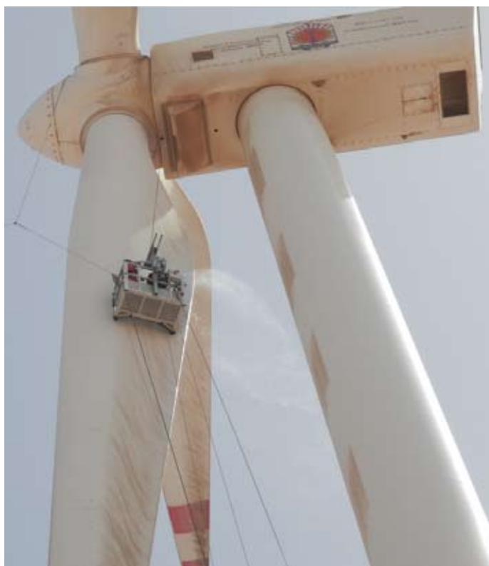
GAMESA G8X, mantenimiento de palas (limpieza)
