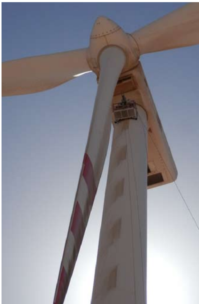
GAMESA G8X, mantenimiento de torre (limpieza)
