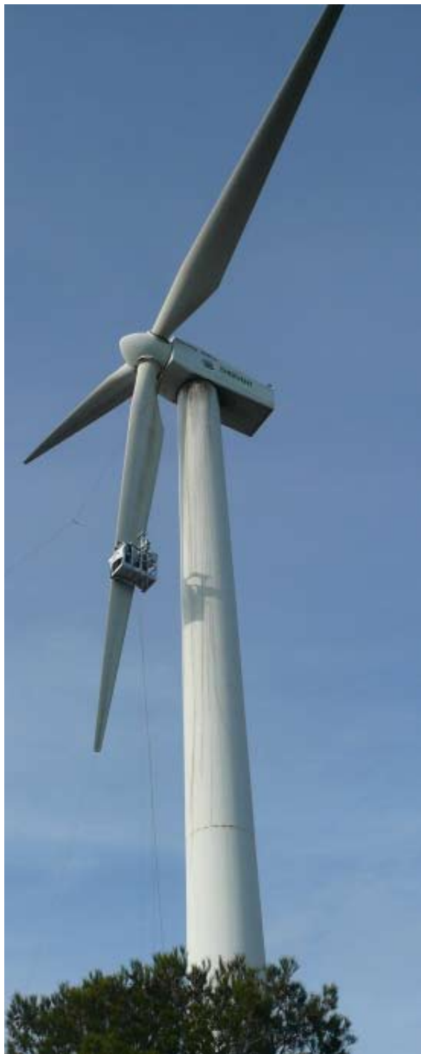
GAMESA G4X y G5X, mantenimiento de palas (fibra)
