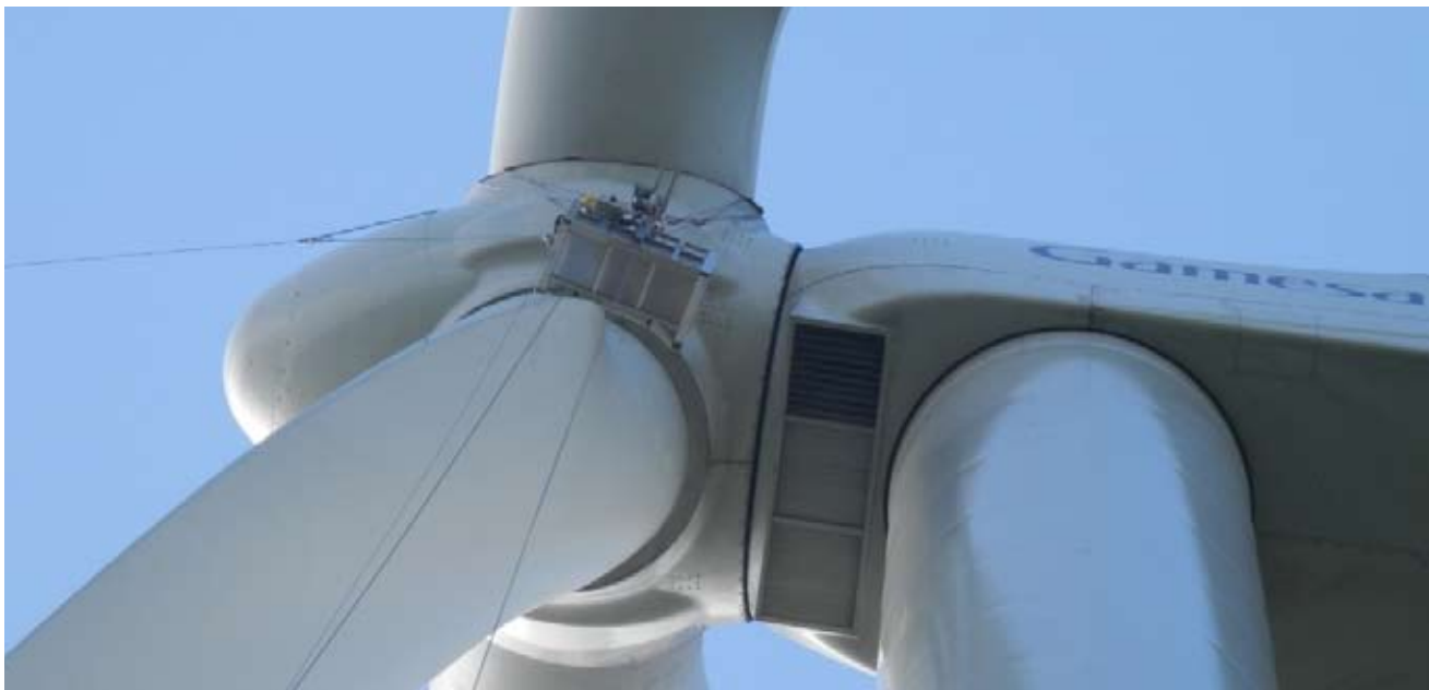
GAMESA G10X, mantenimiento de palas (zona raíz)
