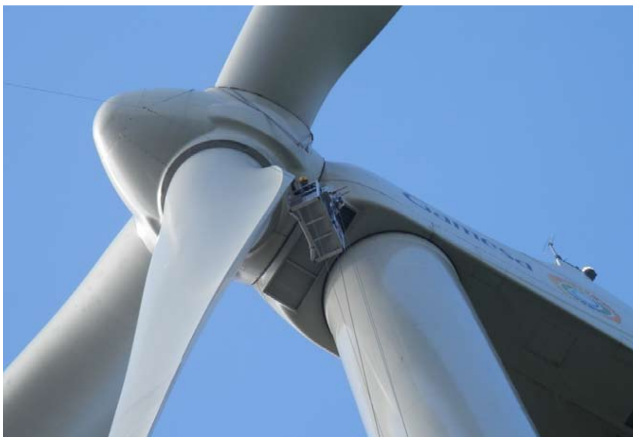
GAMESA G10X, mantenimiento de palas (acceso borde salida)
