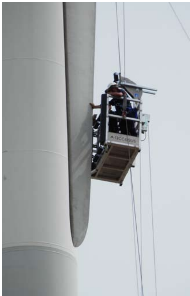
GAMESA G8X, mantenimiento de palas (punta)
