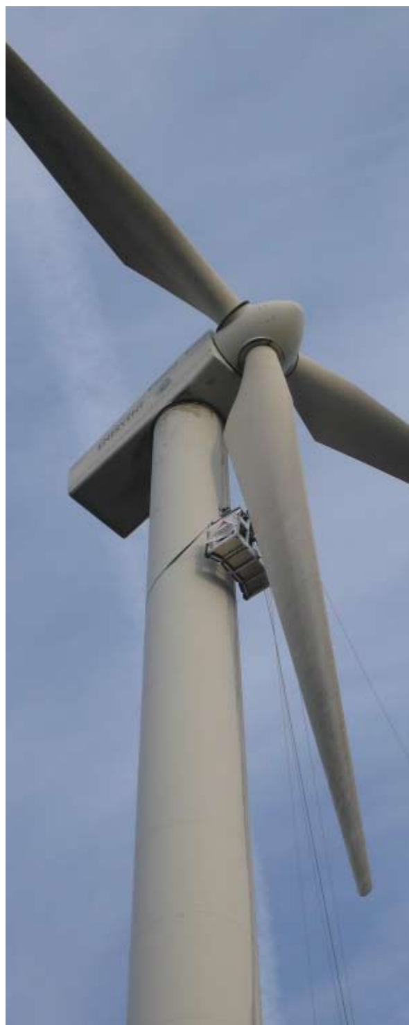
GAMESA G4X y G5X, mantenimiento de torre (limpieza)
