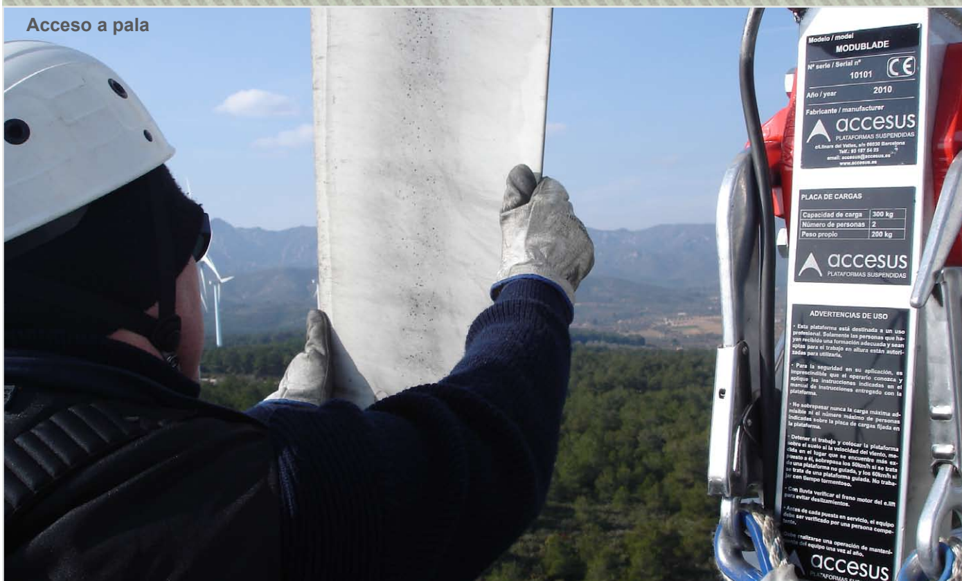
Acceso a pala y torre
