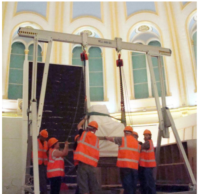
Elevación de obras de arte
