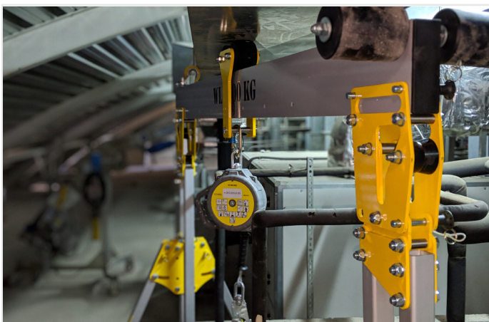
Detalle de pórtico modelo PCP-K en espacio confinado.
