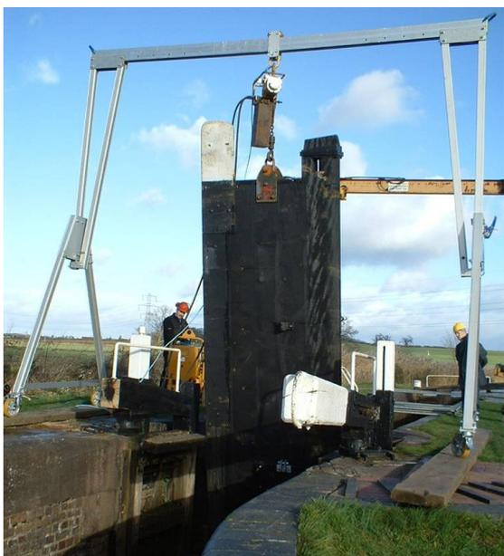
Elevación de compuerta
