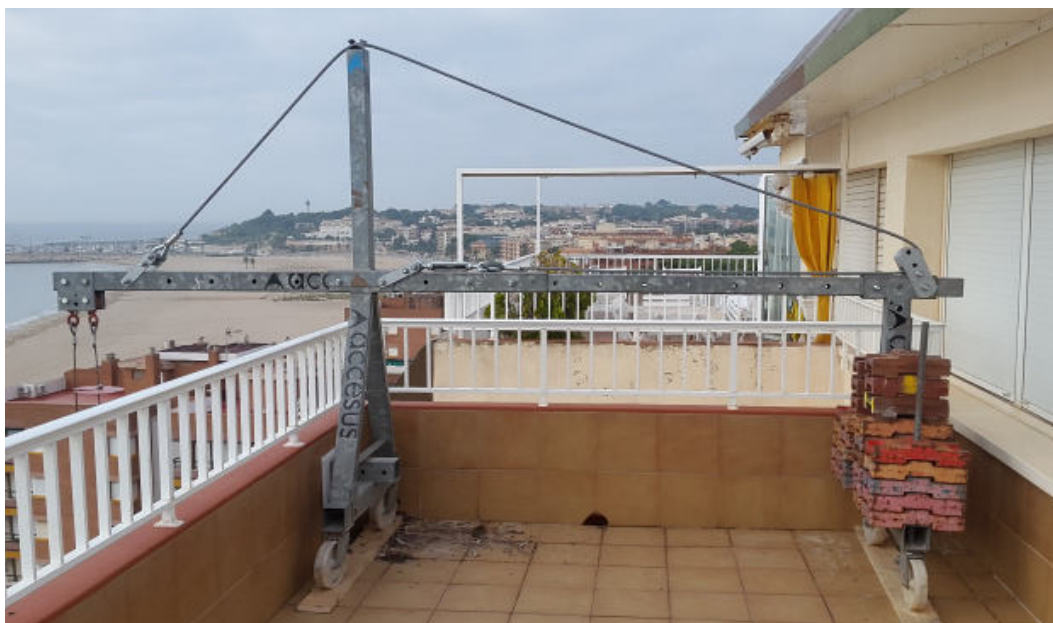
Configuration du BRAKOO modèle 2B avec hauteur de 1,25 mètres et catiliver de 2 mètres.
