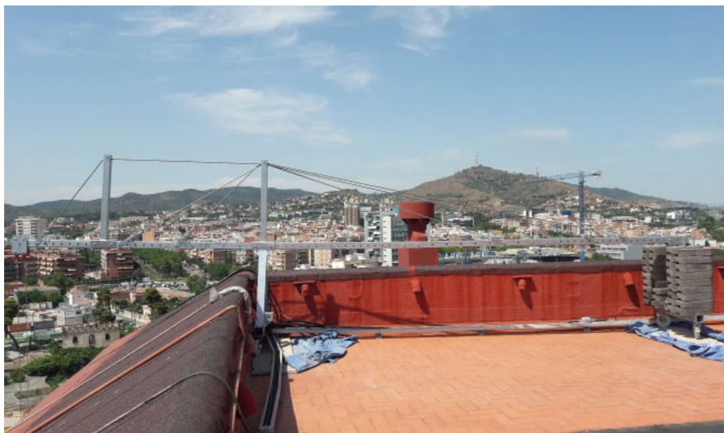
Configuration de bossoir BRAKOO modèle 2D avec une hauteur de 1,25 mètre y cantilever de 3 mètres
