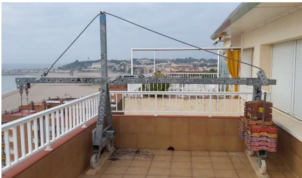
Configuration du BRAKOO modèle 2B avec hauteur de 1,25 mètres et catilèver de 2 mètres.
