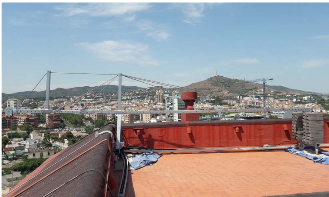
Configuración de pescante BRAKOO modelo 2D con altura de 1,25 metros y vuelo de 3 metros.
