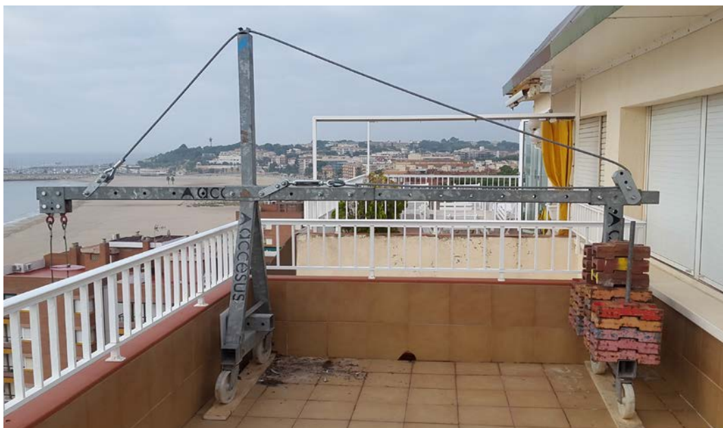
Configuración de pescante BRAKOO modelo 2B con altura de 1,25 metros y vuelo de 2 metros.
