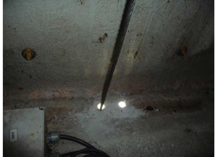
Mientras tanto el operario en la base de la torre debe introducir el extremo de este cable en el elevador y dejar el cable con un punto de tensión pulsando subida en el armario eléctrico. El sobrante de cable se debe enrollar en los aros de enrollador. Ver sección 6.3.2.
