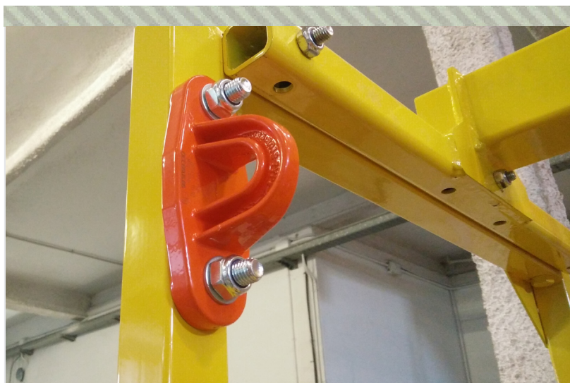
Detalle de PAF 150 en cesta para grúas CG300
