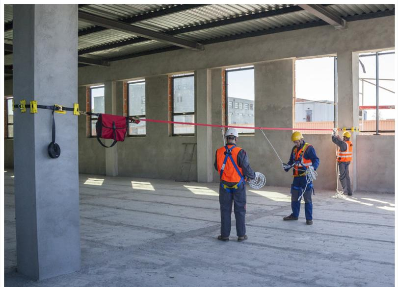
Aplicación real del punto de anclaje de columna LVH 100 y la LVH320.
