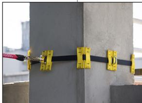
El diagrama y la fotografía muestran cómo se colocaría el punto de anclaje LVH 100 en una columna rectangular.
