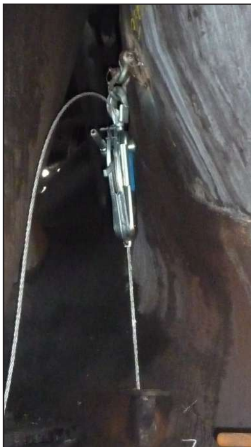
Ejemplo 1: Anclaje en oreja soldada.
