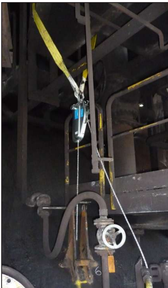
Ejemplo 4: Anclado a estructura existente
