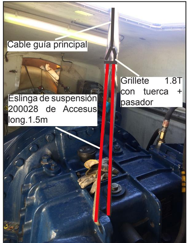
La instalación queda finalizada. Se debe continuar con el montaje de la plataforma e instalación de cables en la plataforma según las indicaciones del manual de instrucciones de la plataforma Modublade.
