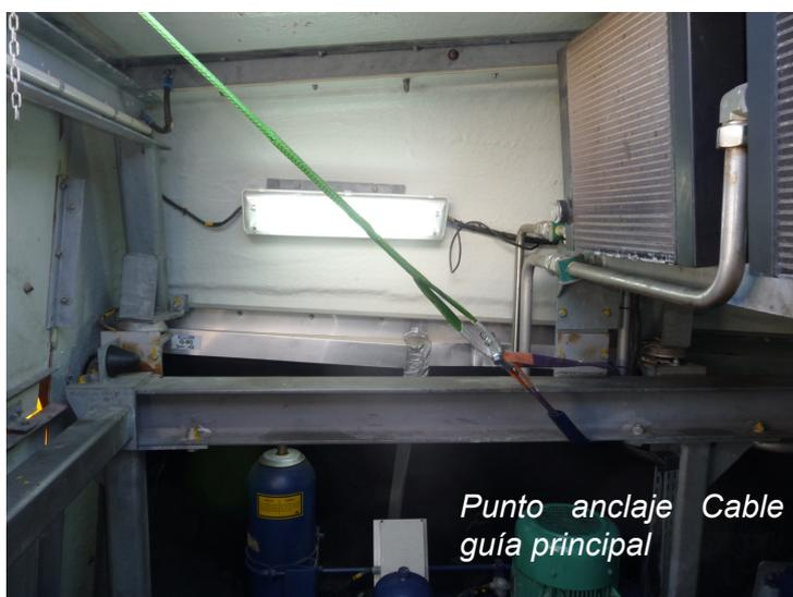
4-Hacemos descender el cable, mediante el enrollador, haciéndolo pasar primero por el anticaídas, la velocidad de descenso del cable se controla manualmente. El anticaídas se instala como seguridad en caso de que se nos escape el cable.
