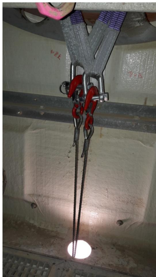
Situación de las eslingas abrazando el eje principal del rotor es la siguiente:
