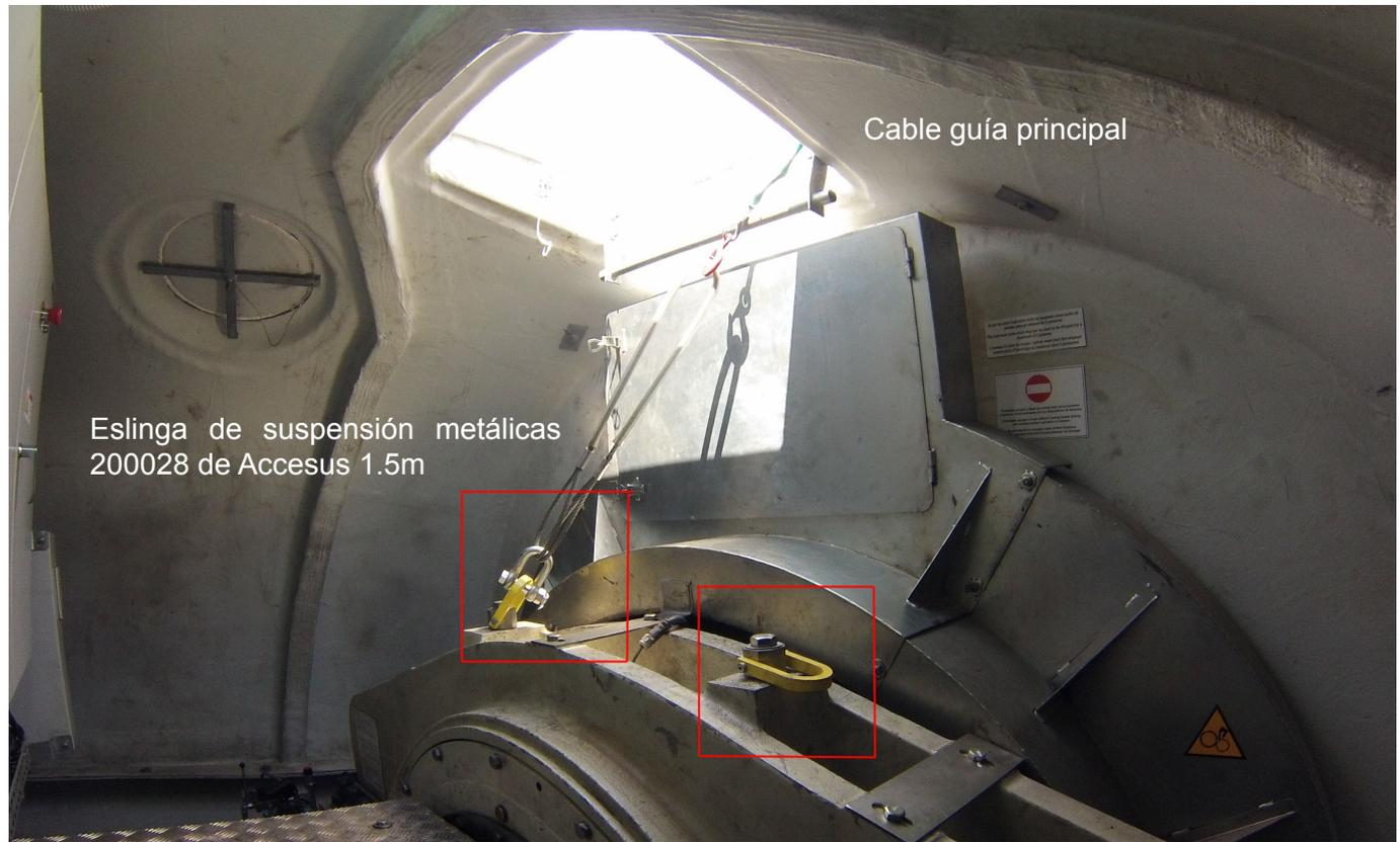
9-Preparamos el anticaídas de cable anclado mediante la eslinga textil de longitud suficiente y un grillete a un punto suficientemente resistente para soportar el peso del cable (0.25kg/m), como uno de los puntos de izado del caballete.
