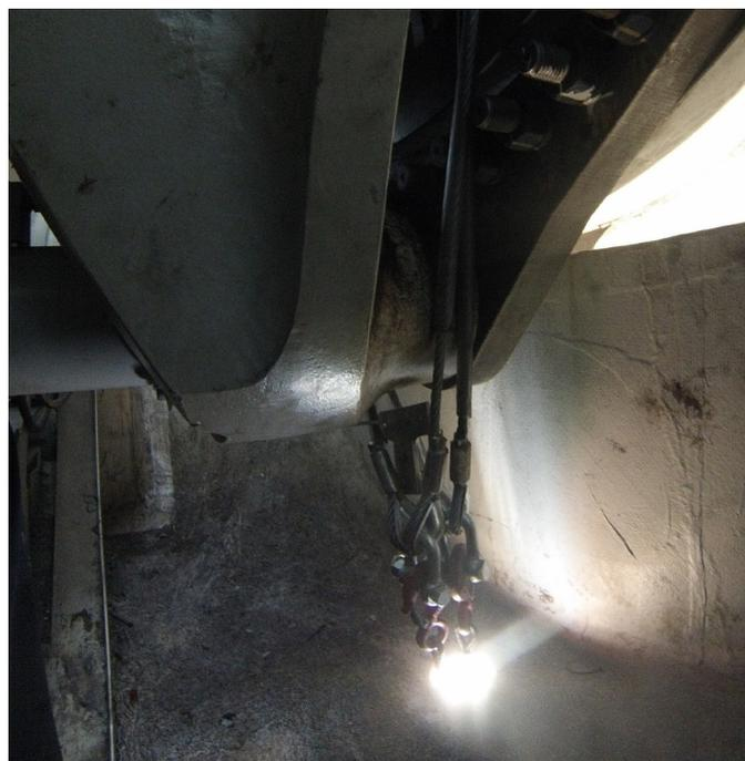
Una vez el cable suspendido de la eslinga el operario en la base de la torre debe introducir el extremo de este cable en el dispositivo anticaídas SECURICHUTE y pasar toda la longitud del cable. El sobrante de cable se debe enrollar en los aros de enrollador. Se debe instalar el contrapeso en el cable para asegurar que el cable de seguridad este en tensión en todo momento. Ver sección 6.3.2 del manual de instrucciones.
