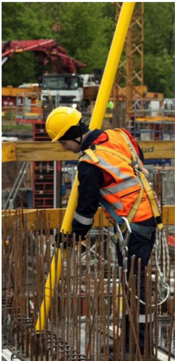
Ejemplos de uso del kit de percha anticaídas PAT 210B.
