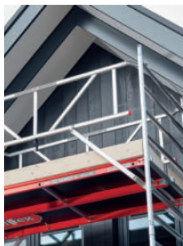
Las torres se entregan con plataformas y rodapiés de madera.
