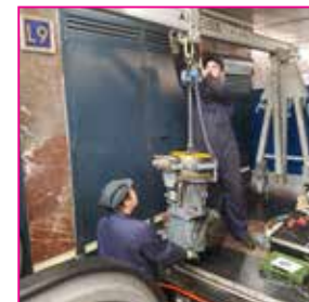
Instalación y mantenimiento de maquinaria.
