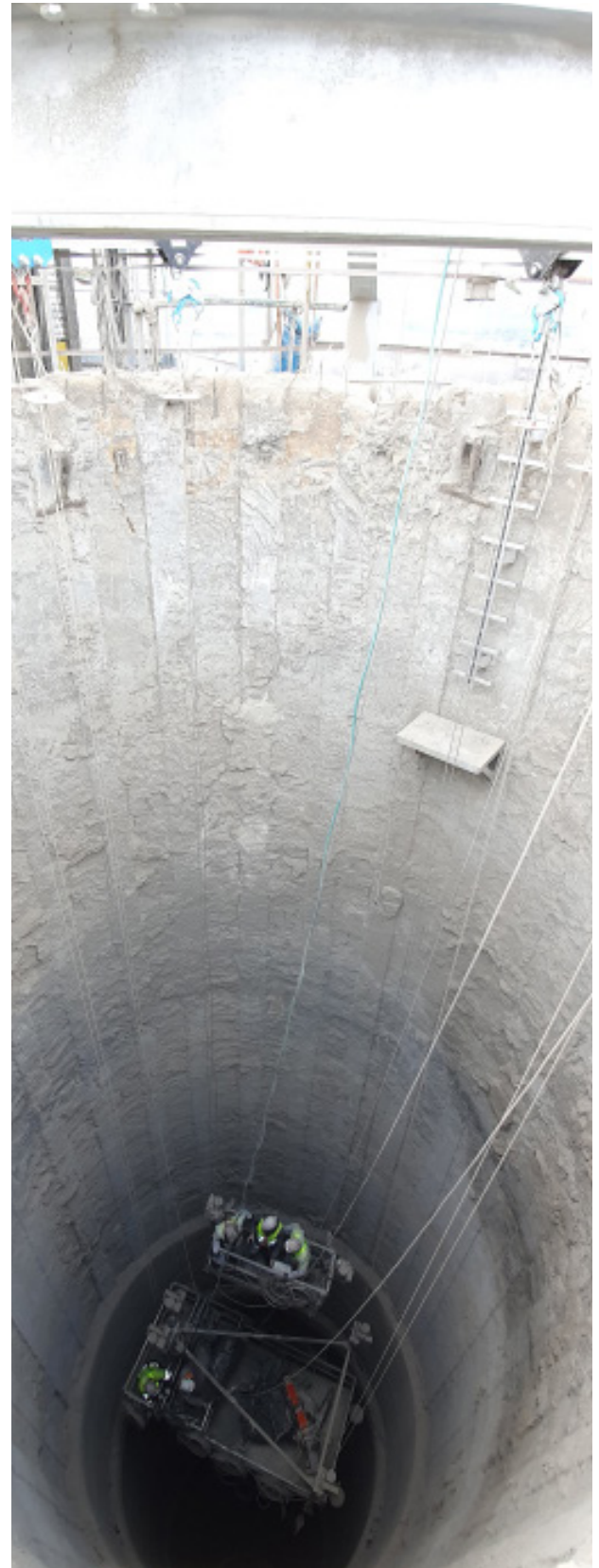
Plataforma auxiliar accediendo a plataforma robot.
