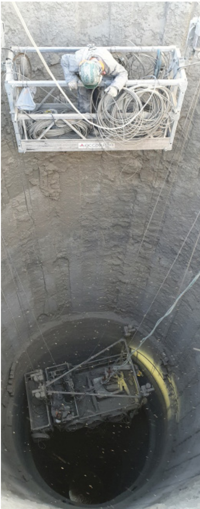
Plataforma auxiliar en coronación, plataforma robot picando
