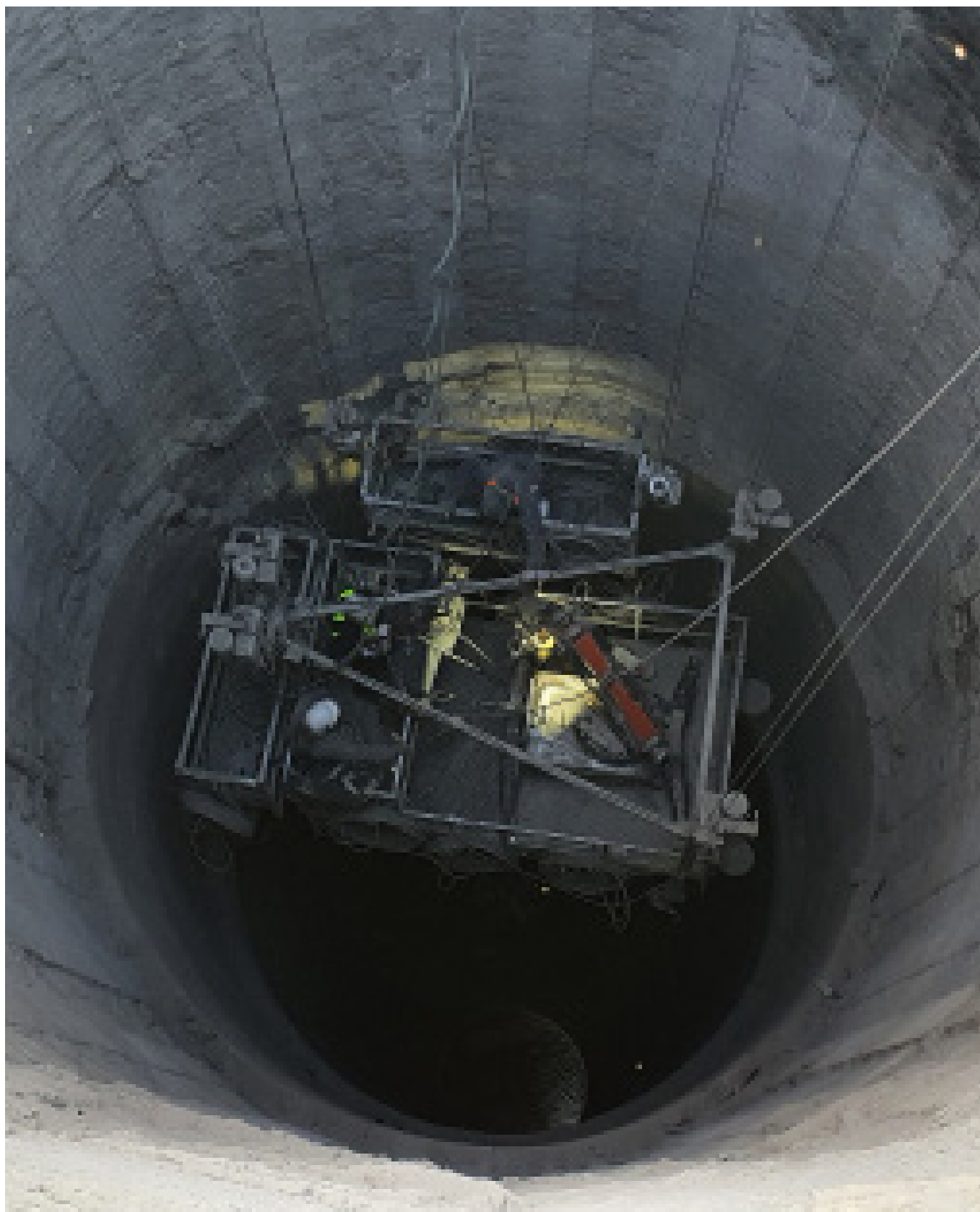
Plataforma auxiliar y plataforma robot
