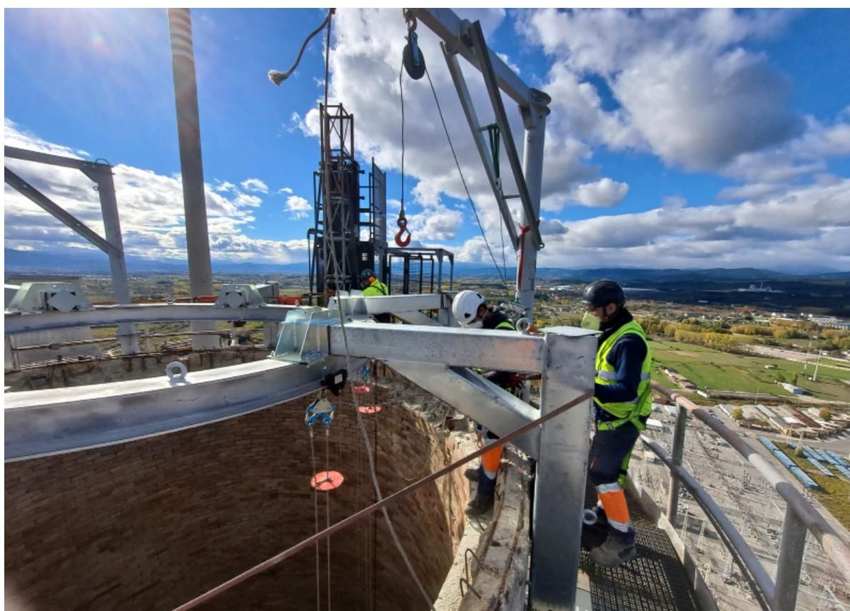
Détail de la phase d'assemblage du rail
