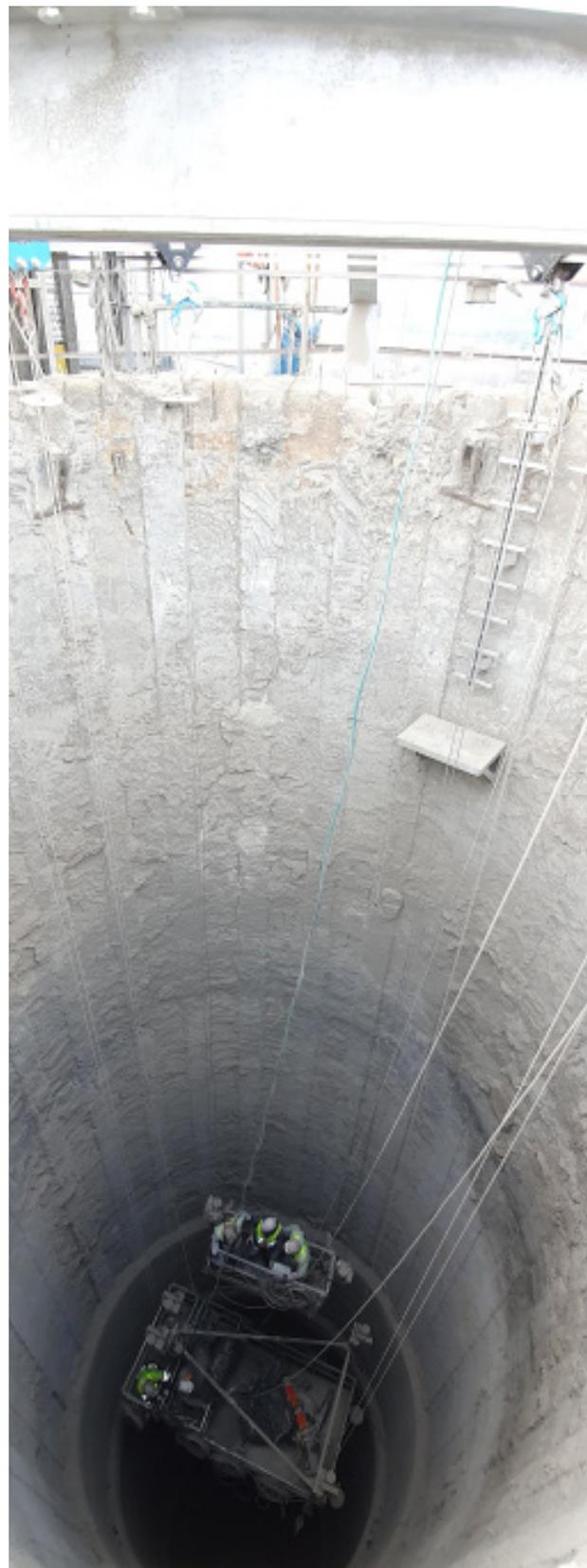
Plate-forme auxiliaire accédant à la plate-
