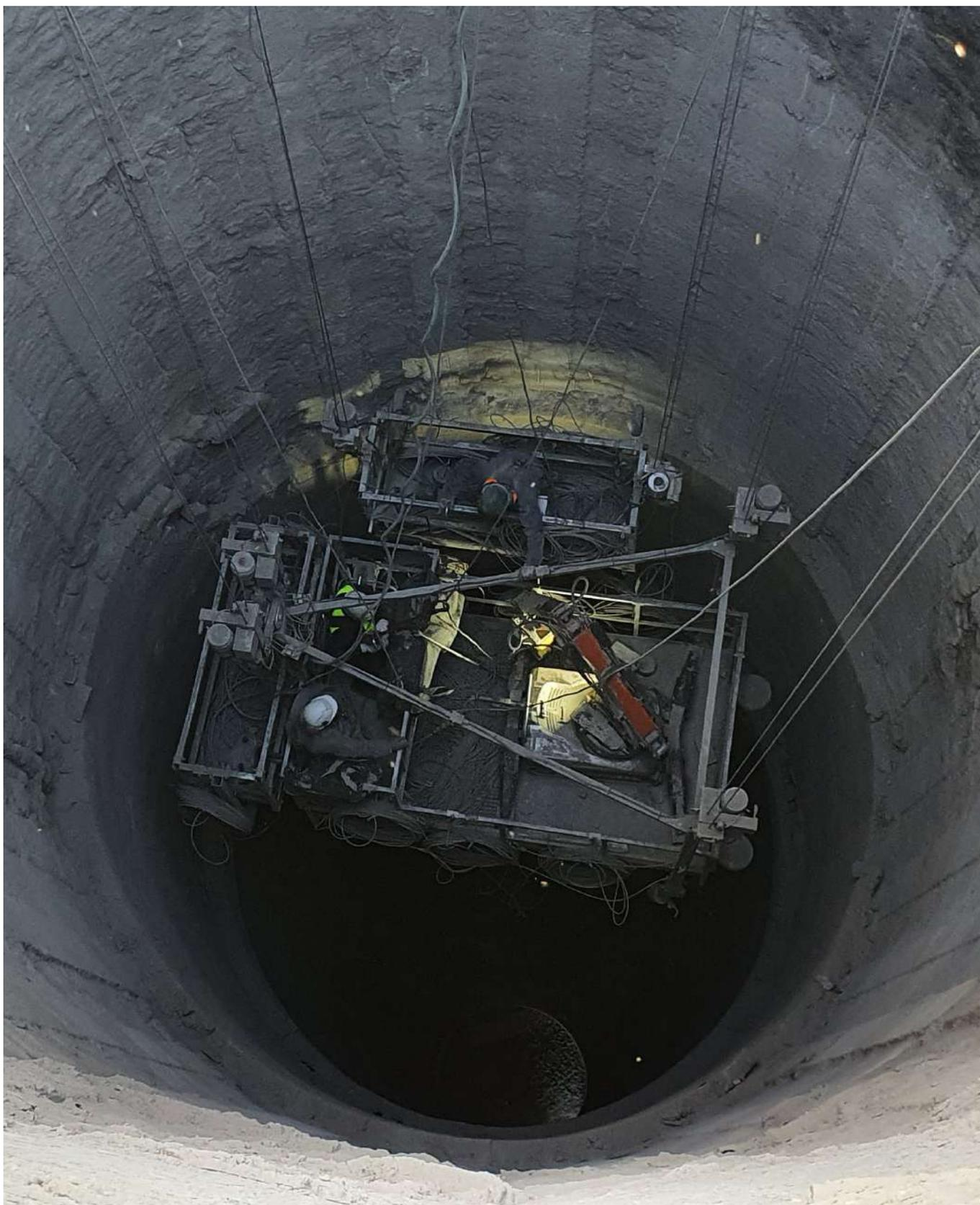
Plataforma auxiliar y plataforma robot
