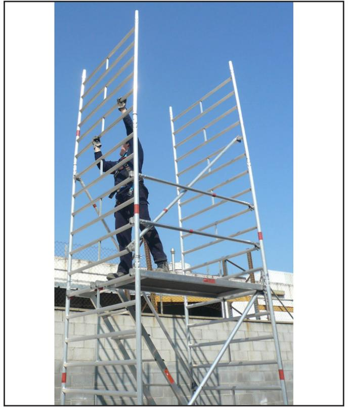
Montar el marco de aluminio 150/6 (4) en la parte superior de la escalera, asegurarlo con los clip (16)
