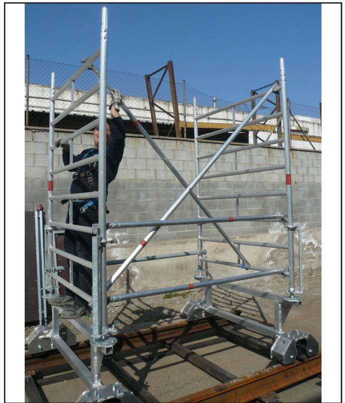
Para estabilizar los marcos de aluminio 150/8 (5) disponer la diagonal 1800 (9) encajándola en el lado de las barandillas y otra opuesta provisional central.
