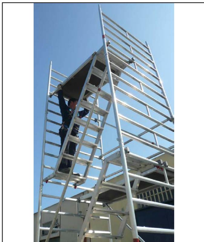
Montar la plataforma 1800 con abertura (6) en la zona de la escalera 1800 con descansillo (10)
