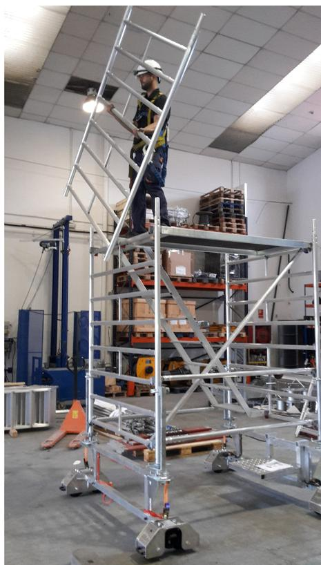
Montar el marco de aluminio 150/8 (4) en la parte superior de la escalera, asegurarlo con los clip (16)
