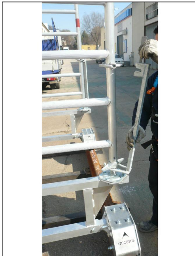
Asegurar la unión mediante la pieza de union para base (17)
