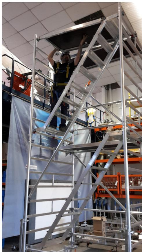
Montar la plataforma 1800 con abertura (6) en la zona de la escalera 1800 con descansillo (10)
