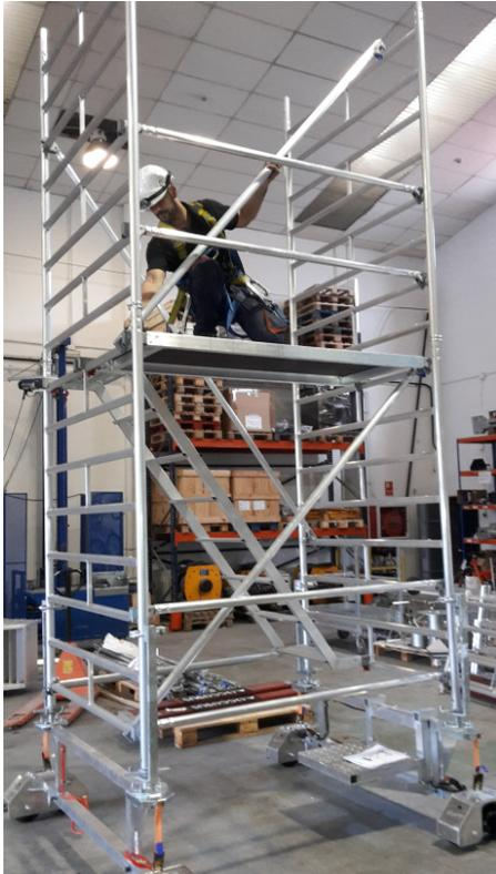
Para estabilizar los marcos de aluminio 150/8 (4) montar la diagonal 1800 (9)
