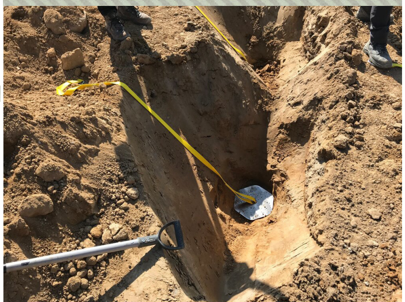
Aplicación práctica del punto de anclaje PAT 189 en obra.
