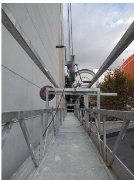
Lyres de passage Accessus 200036 montée sur une plateforme en aluminium de 12 m avec l'élevateur manuel m.lift
