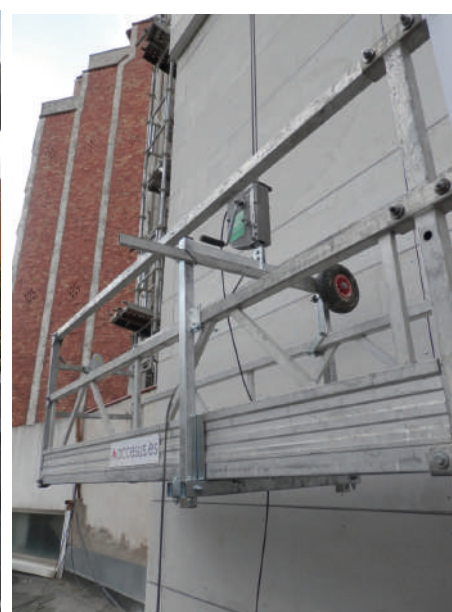
Lyres de passage Accessus 200036 montée sur une plateforme en aluminium de 12 m avec l'élevateur manuel m.lift
