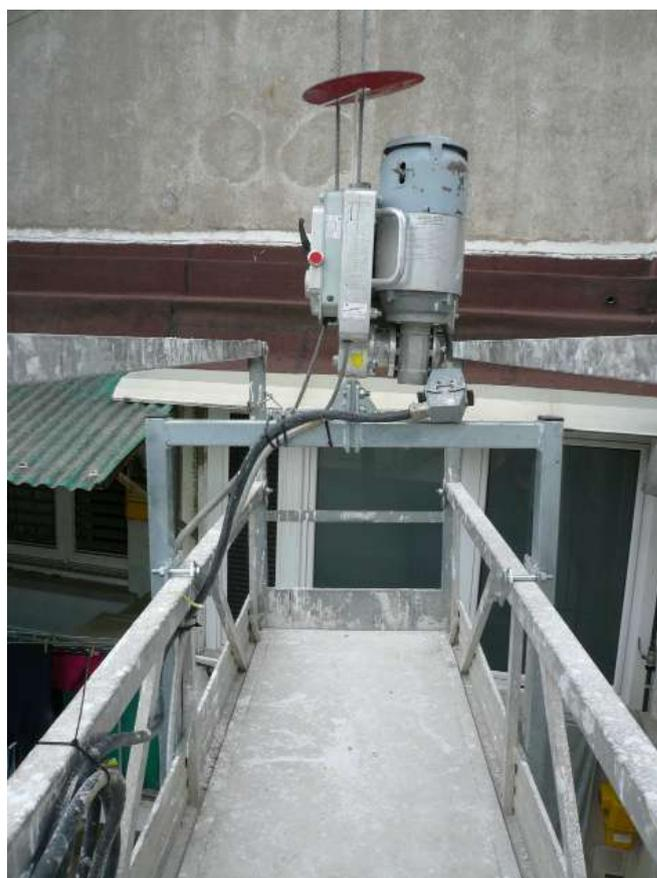
Lira de paso *Accessus 200036* montada en plataforma de aluminio de 4 m con elevador eléctrico-motorizado *e.lift*
