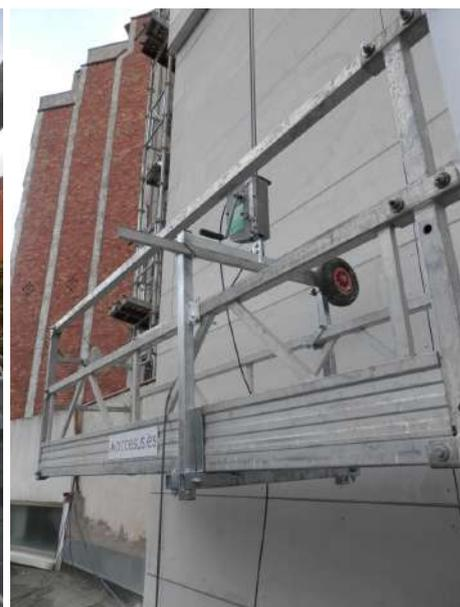
Lira de paso Accesus 200036 montada en plataforma de aluminio de 12 m con elevador manual *m.lift*
